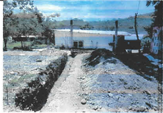
Foto 2: Zanqueo para la construccion del muro perimetral.
