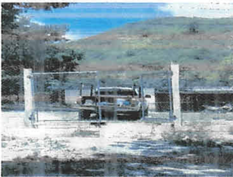
Foto 5: Instalacion del porton de ingreso a la escuela.
